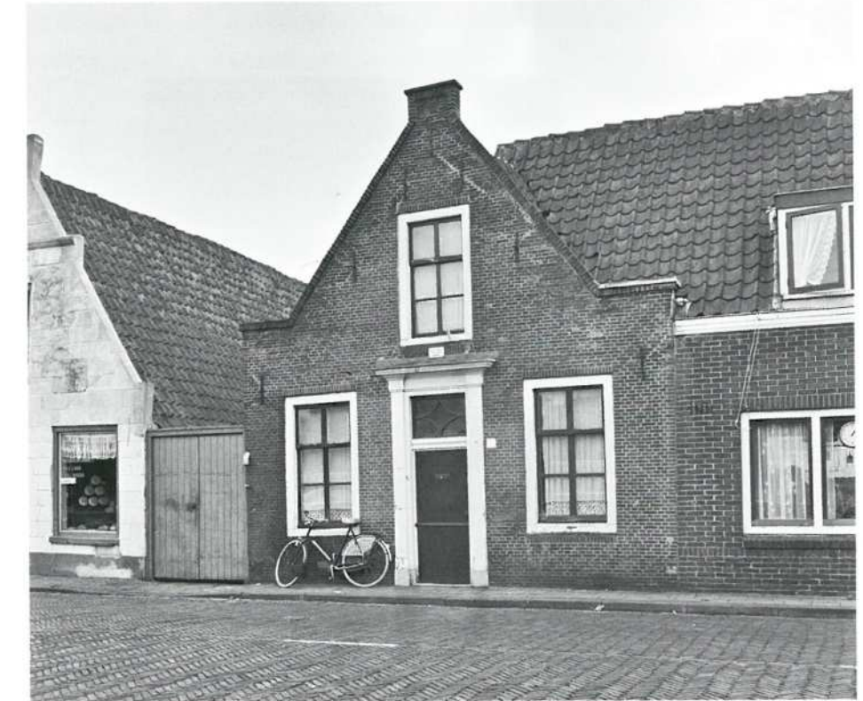
▲ Omstreeks 1968 nog bewoond, met een bordje 'onbewoonbaar verklaarde woning' boven de deur.
